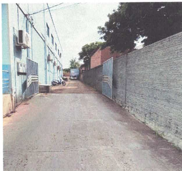
Figura 8: rampa de acesso estacionamento.
